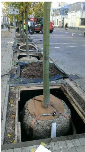
14. Att. Koku dižstādu stādīšana, izmantojot sakņu kamolu enkurošanu, foto: G.Leiburgs, Rīga
