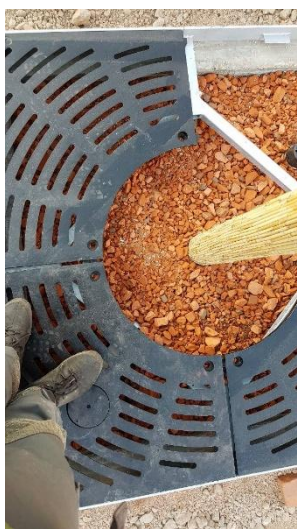
18. Att. Koku dižstādu stādīšana, izmantojot čuguna sakņu aizsargrežģus. Foto G.Leiburgs, Smiltene
