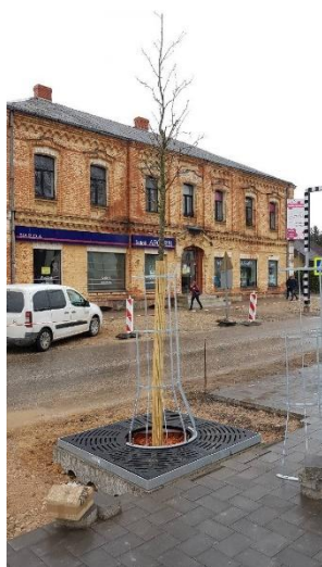
18. Att. Koku dižstādu stādīšana, izmantojot čuguna sakņu aizsargrežģus. Foto G.Leiburgs, Smiltene
