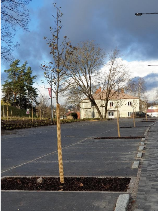
11. Att. Koku dižstādu stādīšana stāvlaukumā “zaļajās saliņās” ar sakņu kamola enkurošanu un stefanandru stādījumu apdobēs, apdobi mulčējot ar priežu mizu mulču , att. G.Leiburgs
