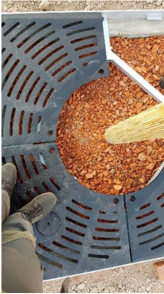
9. Att. Koku dižstādu stādīšana cietajos iesegumos, izbūvējot sakņu aizsargrežģi, apdobi mulčējot ar reciklētu māla ķieģeļu minerālmateriālu, att. G.Leiburgs
