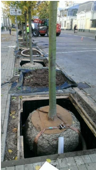
14. Att. Koku dižstādu stādīšana, izmantojot sakņu kamolu enkurošanu, foto: G.Leiburgs, Rīga
