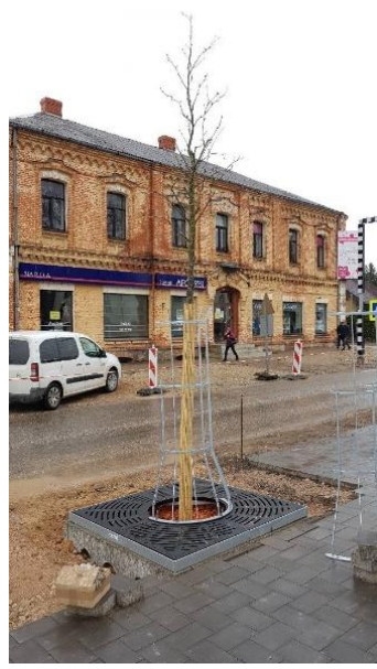
9. Att. Koku dižstādu stādīšana cietajos iesegumos, izbūvējot sakņu aizsargrežģi, apdobi mulčējot ar reciklētu māla ķieģeļu minerālmateriālu, att. G.Leiburgs
